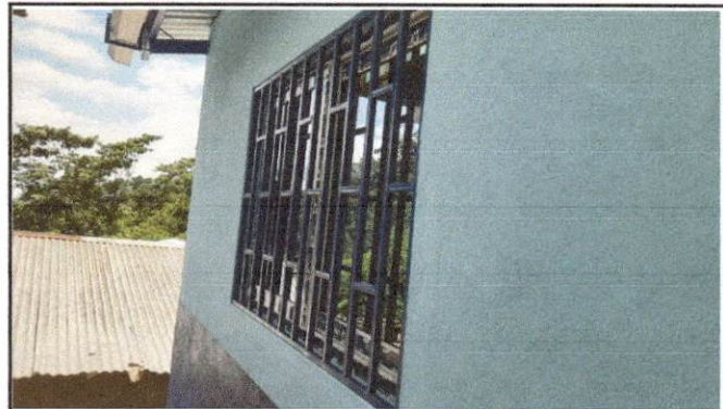
Sustitución de balcones de metal
