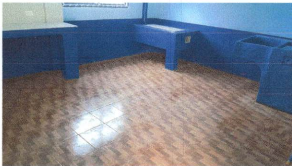
Sustitución de piso cerámico
