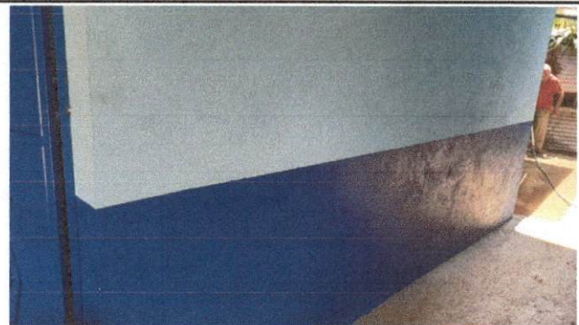
Reparación de muro perimetral de block.
